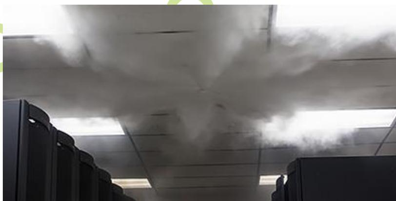
Descarga de una boquilla contra incendios en un datacenter. El fluido de protección contra incendios 3M™ Novec™ 1230 es un agente limpio sintético de última generación, diseñado para equilibrar los aspectos de la seguridad de las personas, la eficacia y el medio ambiente.
